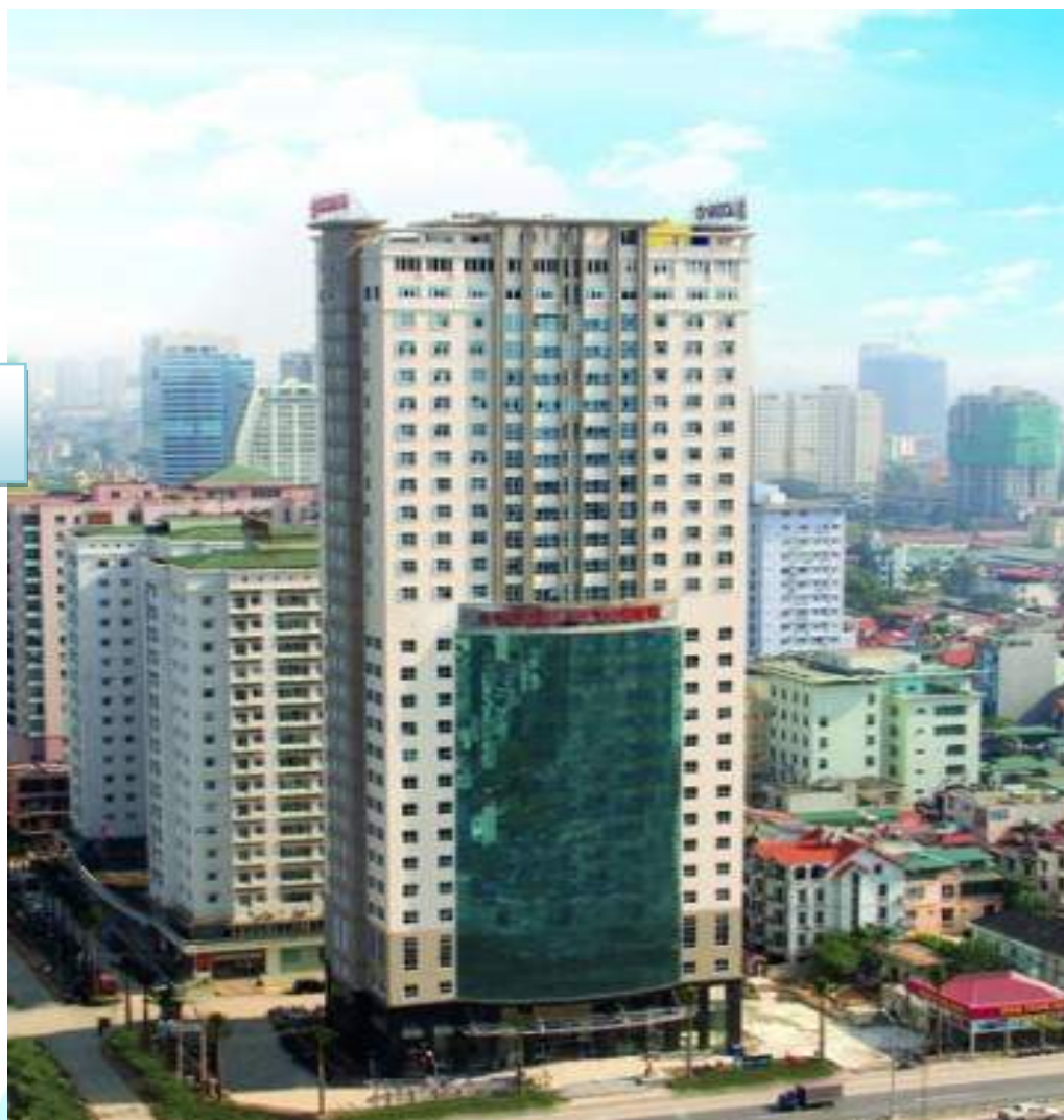
TÒA NHÀ LICOGI 13
